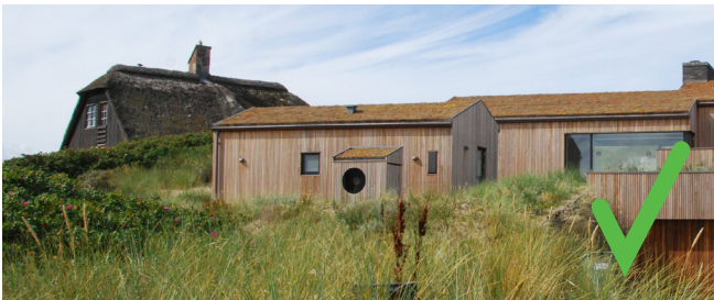
Varmepumpe godt integreret med boks på facaden.
