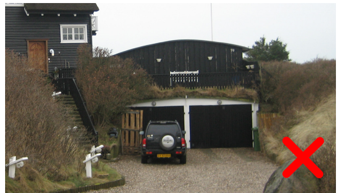
Det fritlagte kælderareal er for bredt, der er 2 garageporte og indkørslen for bred.
