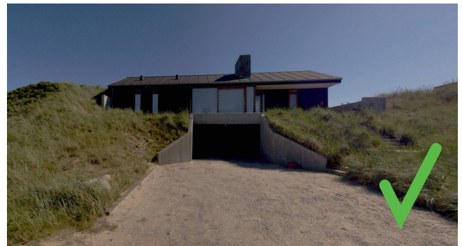
Kælder ikke synlig ud over indkørsel til garagen.
