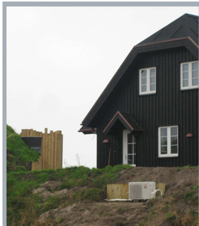
Illustrationen viser et sommerhus, hvor anlægget IKKE er inddækket eller placeret på facade/gavl .
